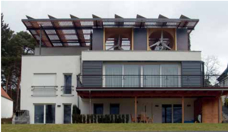
Wohn- und Geschäftshaus in Bad Saarow mit einem „Energiedach“. Quelle: EA EnergieArchitektur GmbH
